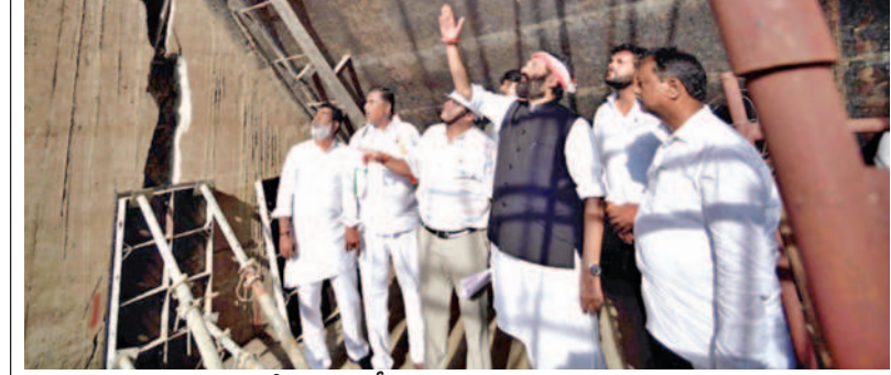
శుక్రవారం పార్వతి బ్యారేజీ వద్ద తనిఖీలు నిర్వహిస్తున్న మంత్రి ఉత్తమ్ కుమార్ రెడ్డి తదితరులు
